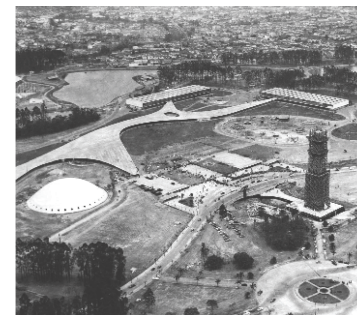
Vista aérea do Parque do Ibirapuera durante as comemorações do IV Centenário da capital paulista, em frente ao Obelisco, ainda em construção, São Paulo, 1954
