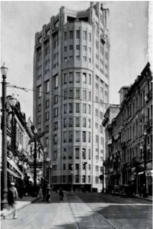
Vista do Edifício Saldanha Marinho na rua Libero Badaró. São Paulo. 1947.
