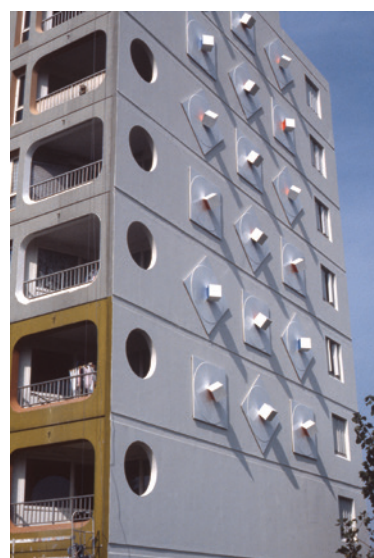
FIG. IV Mural, 1987 Edifício "Les Cascades", Isle d'Abeau, Villefontaine, França FOTO © DANIEL MONTRITY
